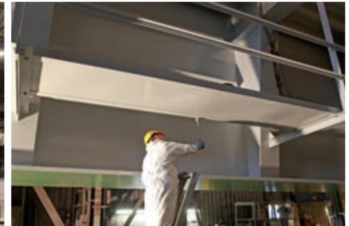
Les opérations d'assemblage terminées, le tronçon neuf est revêtu d'une couche de peinture anti-corrosion.
