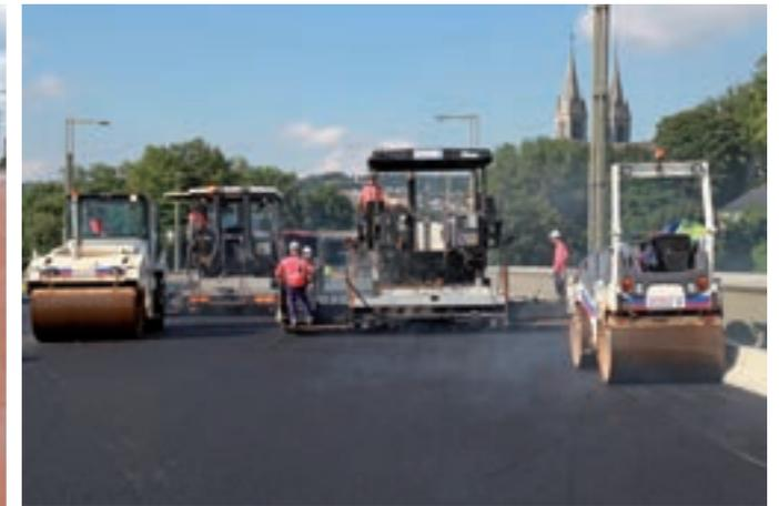
L'entreprise Viafrance intervient pour préparer le support par grenailage et appliquer la membrane bitumineuse qui garantira l'étanchéité de la travée métallique, puis la couche de roulement est posée. Cette intervention a lieu sur les deux travées métalliques du pont Mathilde.
