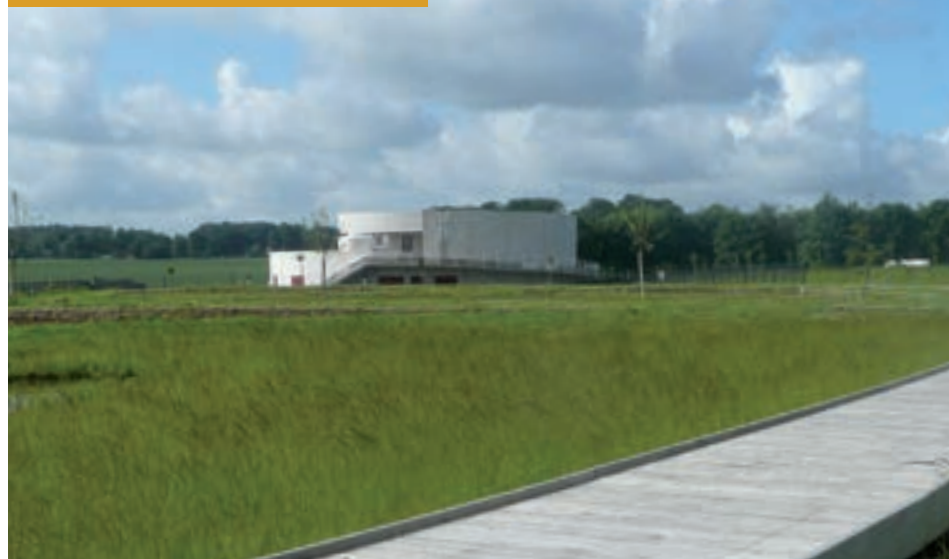
L'usine de production d'eau potable et la station d'épuration sont réunies dans le site paysager du Pôle Eau de Fauville Ouest en Cœur de Caux
