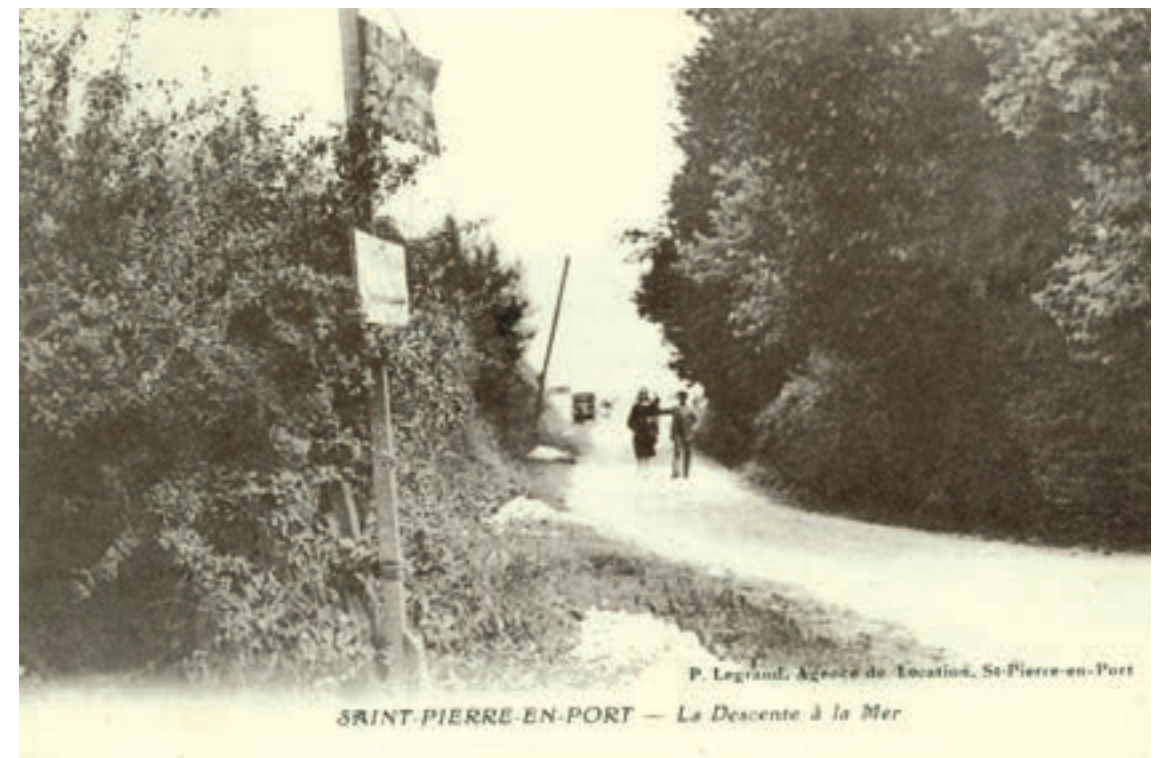
Cliché vers 1925. Chemin d'accès à la plage.
